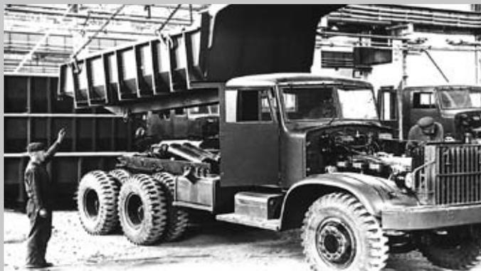
Установка платформы на КрАЗ-222 в сборочном цехе, 1960 г.
